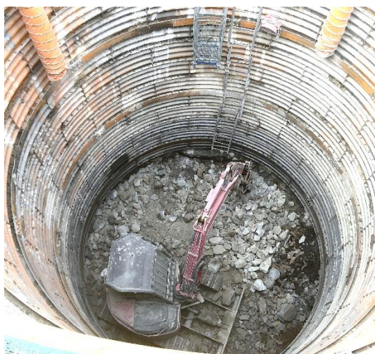
図 2.7.2-31 掘削状況写真
