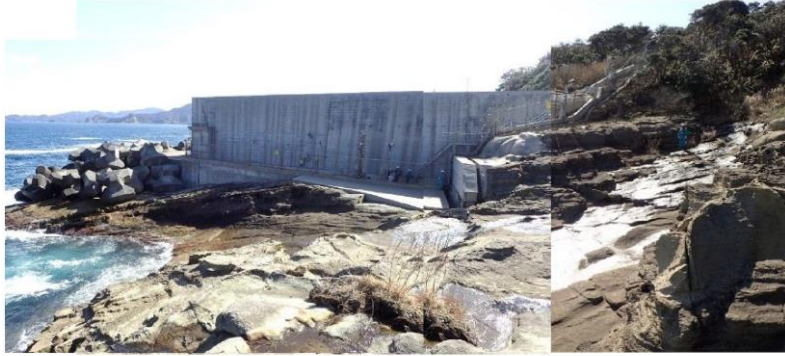
図 1.2-15 防波壁（西端部）地山状況
