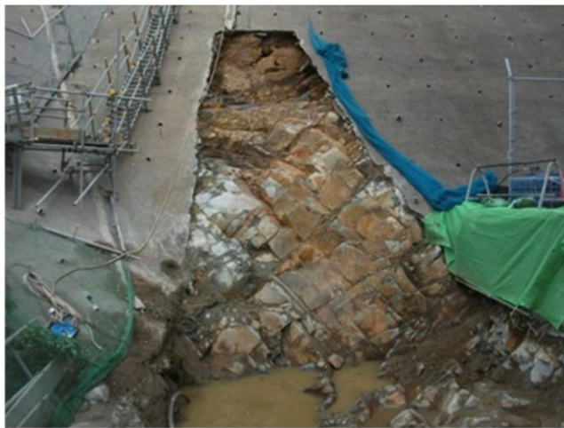
図 1.2-10 防波壁東端部 岩盤露出状況
