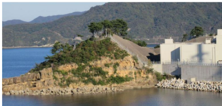
図 1.2-14 防波壁（東端部）地山状況
