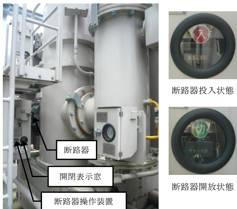
図 1-27 断路器の外観（開閉状態確認イメージ）
