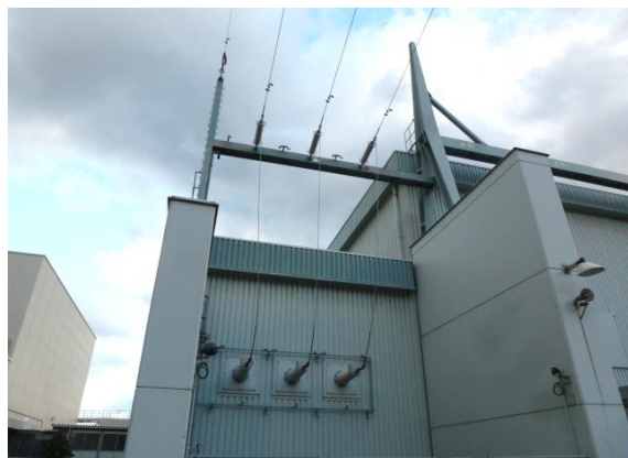
(66kV 開閉所 送電線引込部イメージ)
