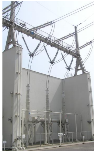
(220kV 開閉所 送電線引込部イメージ)
