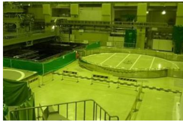
原子炉建物原子炉棟内オペフロ全体
