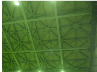
原子炉建物天井
