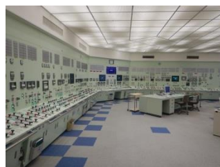
非常用照明点灯時
