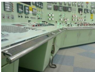
手摺設置状況
