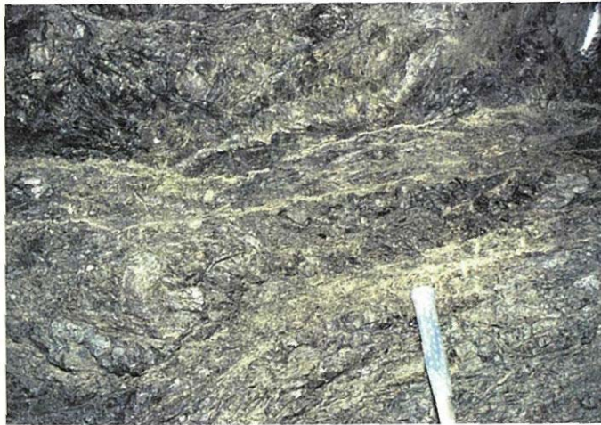
写真-1.5 中・古生代の緑色岩中のシーム(節理や小規模な断層沿いに熱水変質を受けて、幅 1cm 程度以下の多数の粘土化した脆弱なシームが複雑に発達して擾乱帯の様相を呈する)
