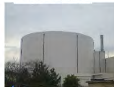
原子炉格納施設外観
