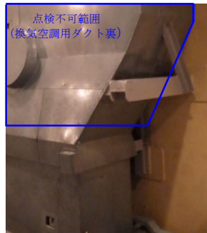
図3. 10 点検不可範囲の例（換気空調用ダクト裏）
