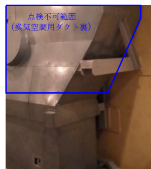
図5. 1 接近可能だが要領書で定めたデータ採取方法の要求条件が確保できない範囲の例 (高浜4号炉の写真)
