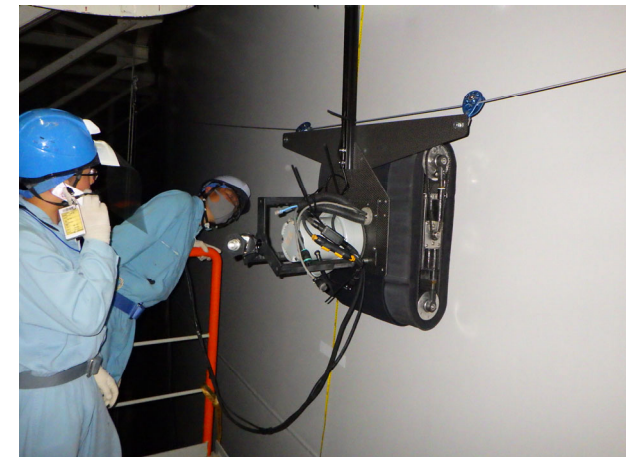
事前検証における 当社社員による立会いの様子
