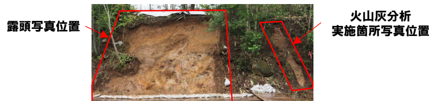
WN1地点全景写真
