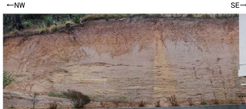
露頭写真(G-01露頭 NE面)
