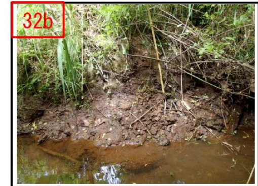
露頭状況写真
