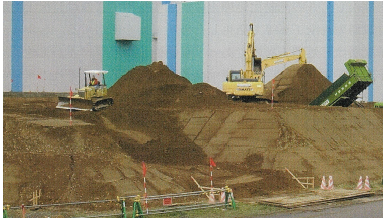
ストックパイル仮置き状況①
