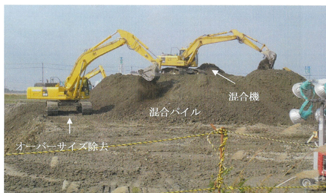
混合・攪拌状況②
