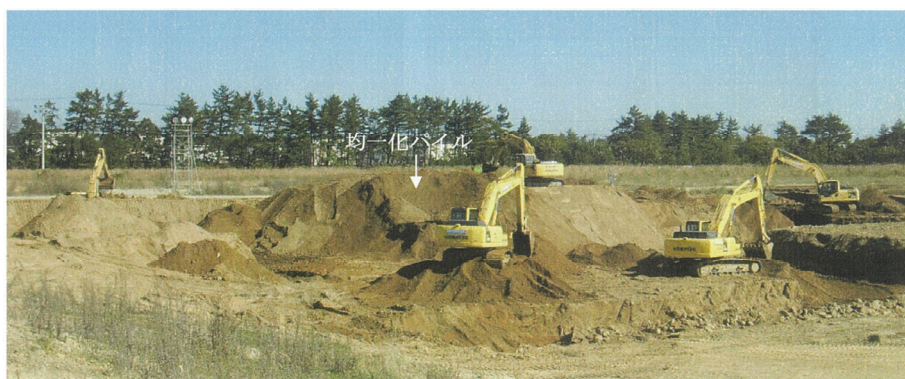
混合・攪拌状況①
