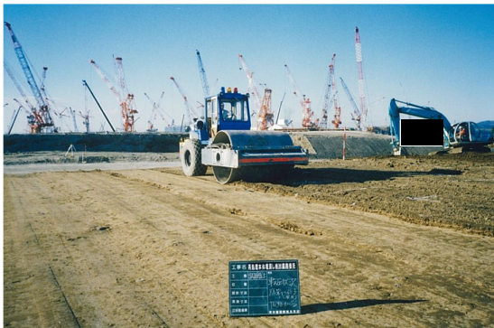
振動ローラー転圧
