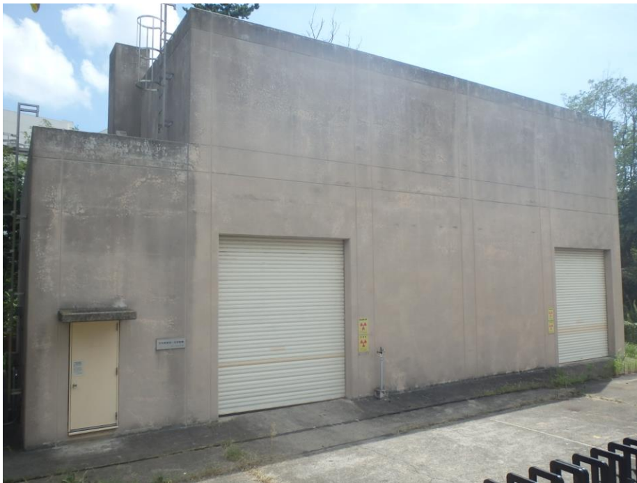
固体廃棄物一時保管棟 外観
