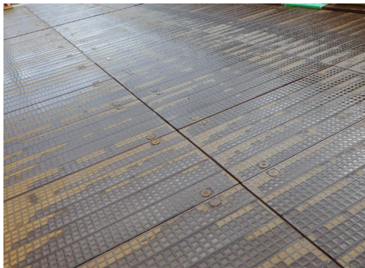
(覆工板の敷設状況)
