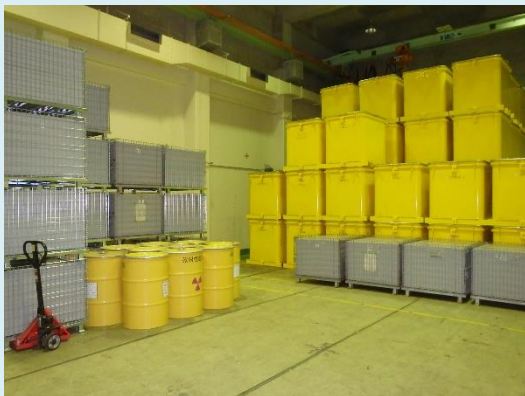
固体廃棄物一時保管棟
