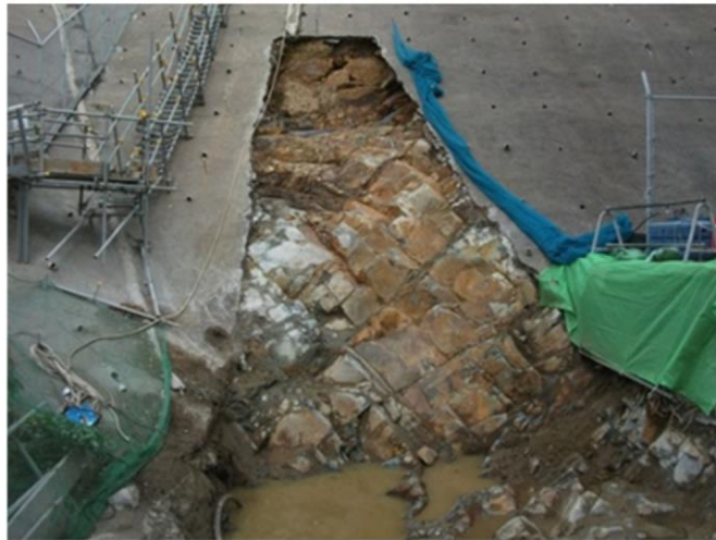
图 1.2-10 防波壁東端部 岩盤露出状況
