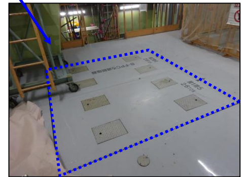
図1 CUW・FPCろ過脱塩器室
