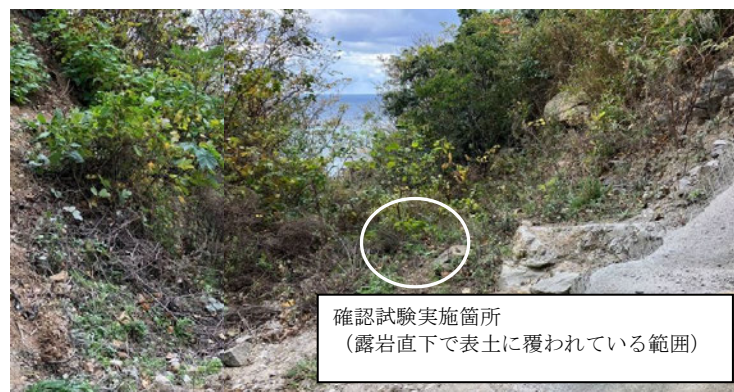
図 2-14 確認試験実施箇所拡大写真
