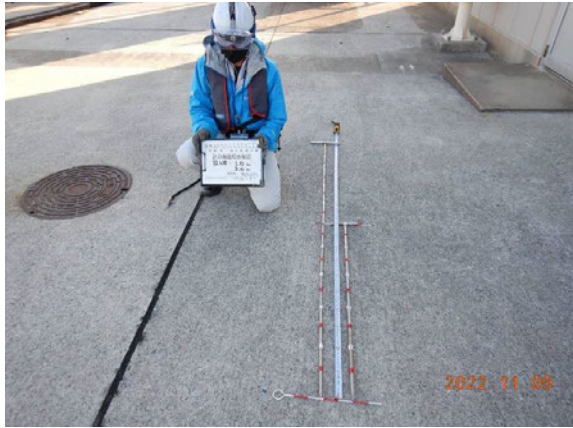
(a) 使用鉄筋棒全景
