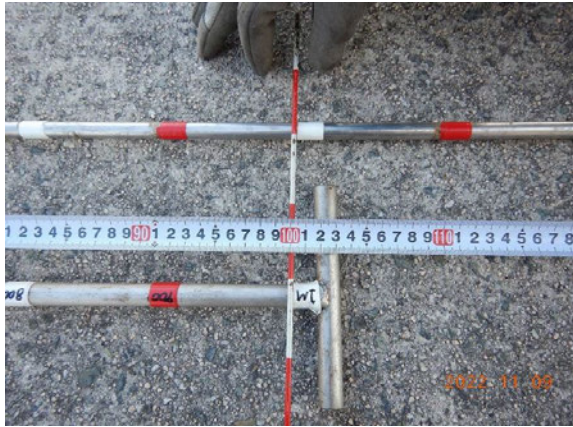
(c) 使用鉄筋棒延長確認
