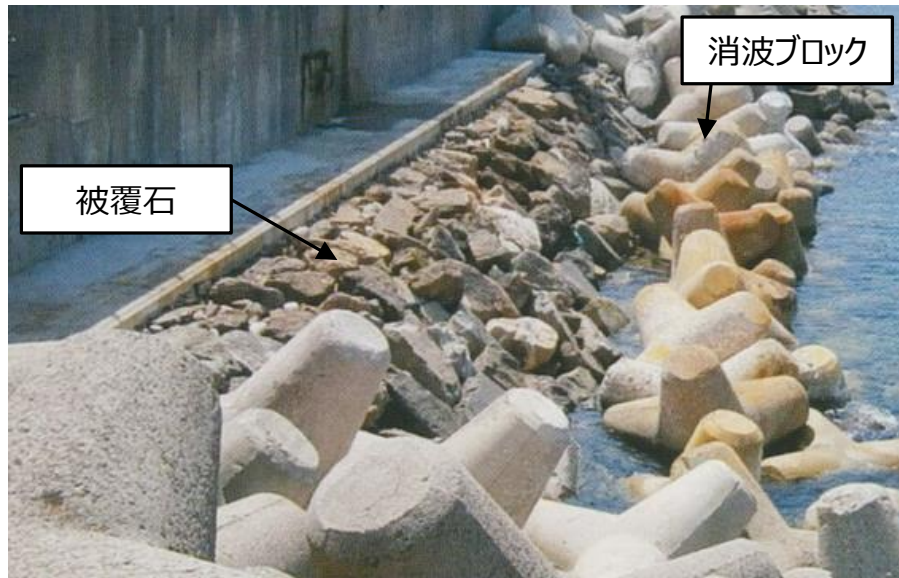
被覆石の設置状況（1，2号機北側護岸）
