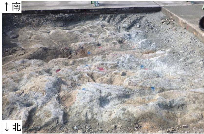
图 4-5 岩盤露出狀況（凝灰岩（C H 級））
