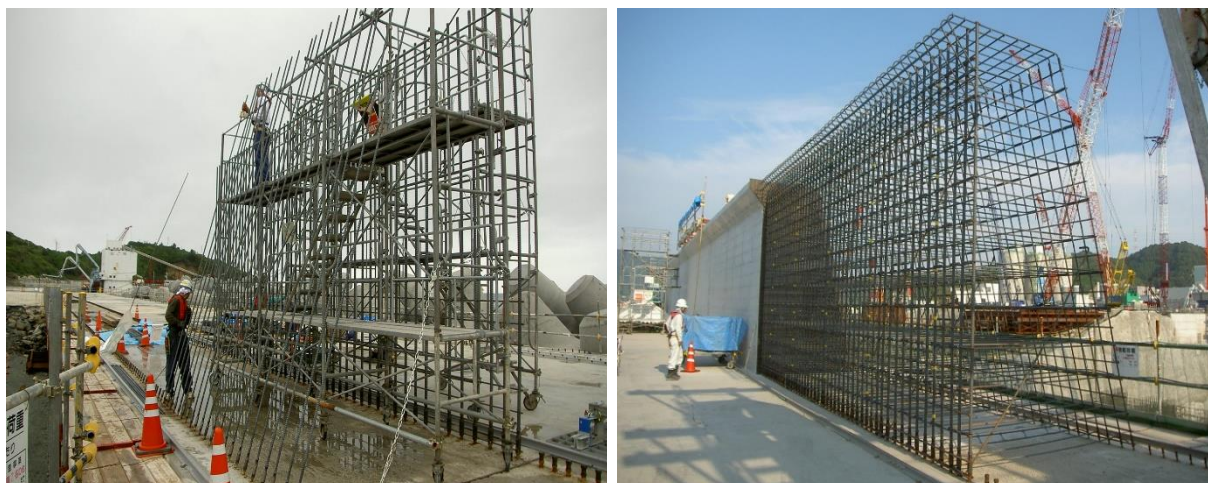
1. 既設部分の主筋組立
