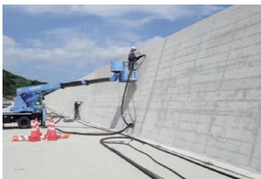
1. 既設部分の目荒らし
