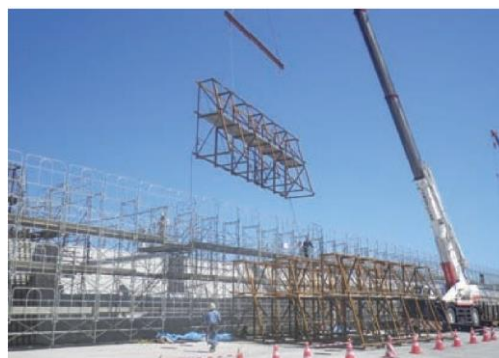
2. 鉄筋架台の設置
