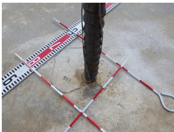
(a) 「浮き」除去前
