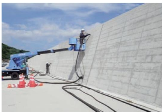
1. 既設部分の目荒らし
