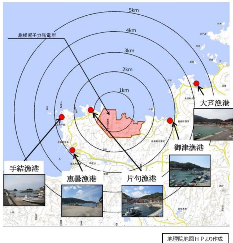
図 4.5.2-1 発電所周辺の地形
