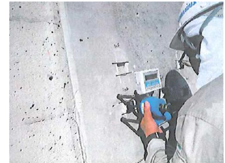
図6 付着強度試験実施状況
