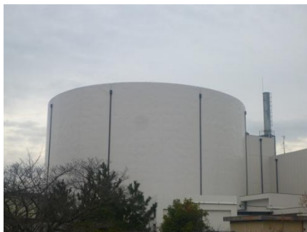
原子炉格納施設外観
