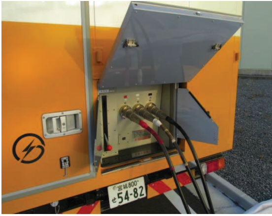
電源車ケーブル接続
