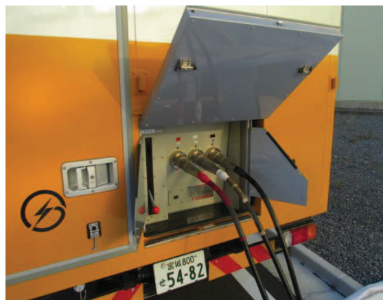
電源車ケーブル接続
