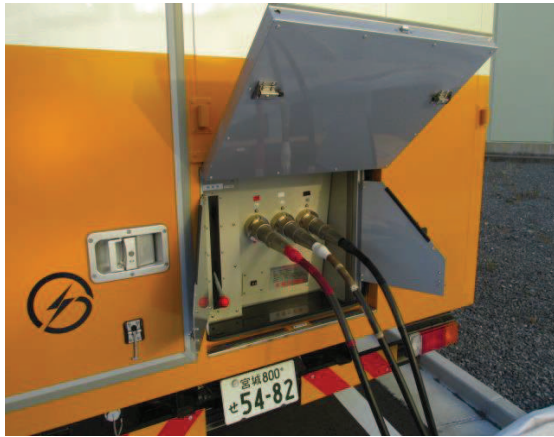
電源車ケーブル接続
