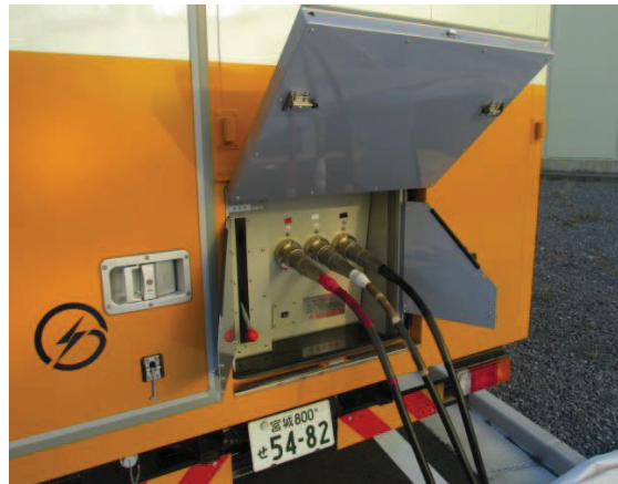
電源車ケーブル接続
