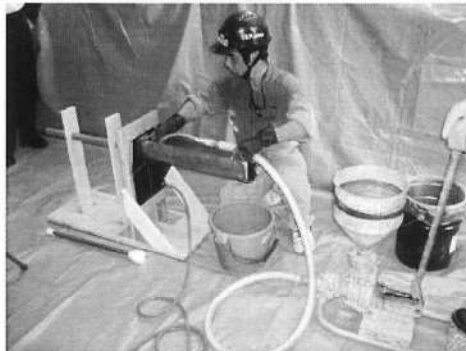
グラウトの充てん状況
