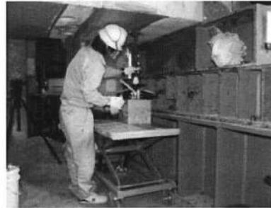
「セラミックキャップバー（CCb）」の挿入
