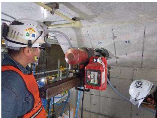
参考 2-1 図 削孔状況
