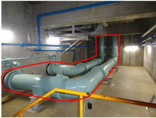
原子炉補機冷却海水排水配管 (電機建屋敷設状況)
