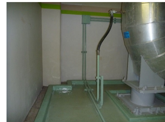
タービン建屋 内壁及び床
