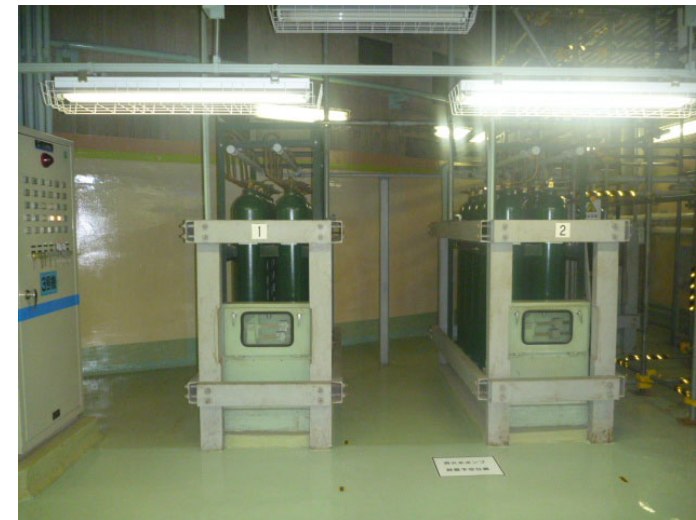
原子炉格納施設等 基礎マット
