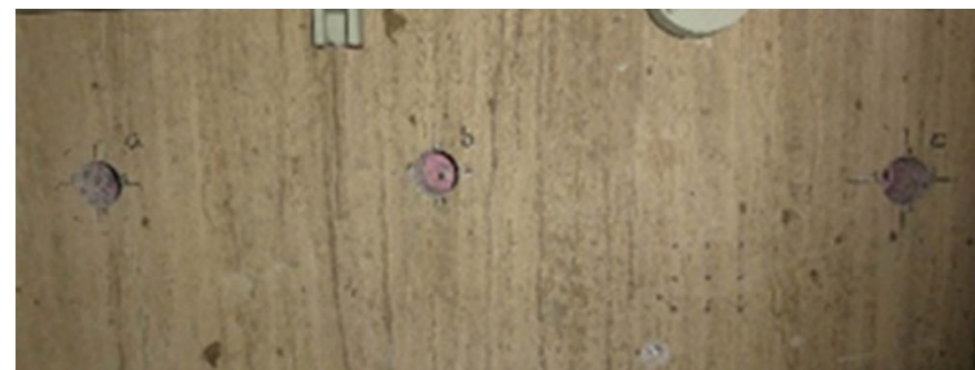
中性化の点検状況
