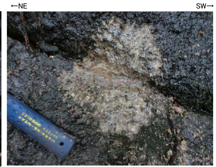
露頭写真(拡大②) 割れ目はおおむね密着し、周囲は固結しており破碎は認められない
