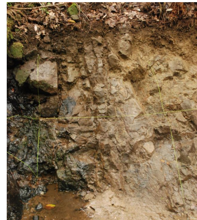
写真② 安山岩(均質)に発達する板状割れ目 (上:割れ目を加筆, 下:加筆なし)
