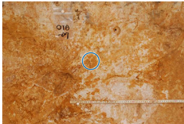
試料採取箇所写真(OTB-07)
