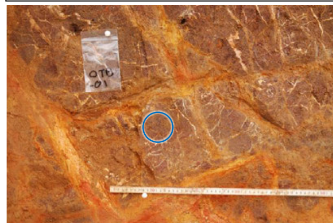
試料採取箇所写真(OTB-01)
