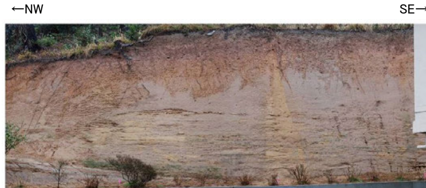
露頭写真(G-01露頭 NE面)
