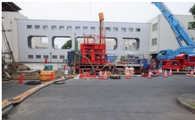
地盤改良の試験施工
