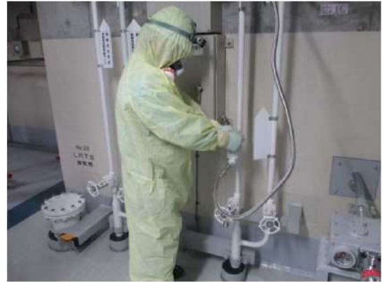
(制御用空気供給弁閉操作イメージ)
