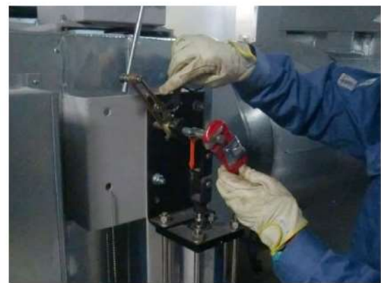
(空気作動ダンパ閉作業イメージ)
