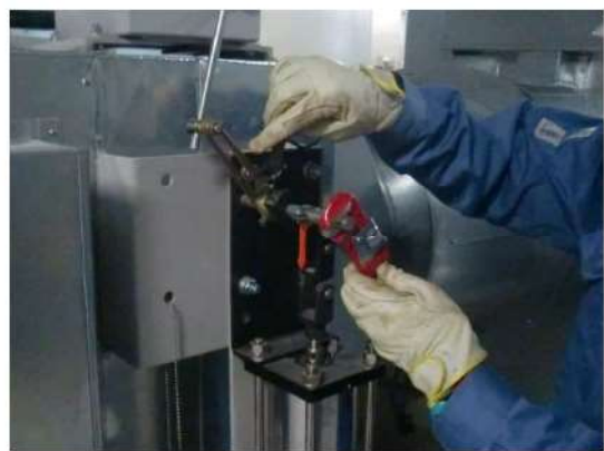
(空気作動ダンパ開作業イメージ)
