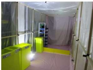
可搬型照明①
