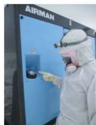
可搬型直流電源用発電機 給油口 （可搬型直流電源用発電機） （屋外）
