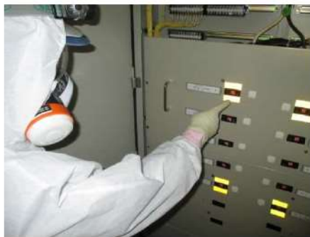
不要直流負荷切離し操作 （安全補機開閉器室） （原子炉補助建屋T.P. 10. 3m）
