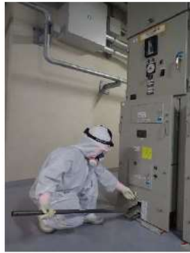
受電遮断器操作 (安全補機開閉器室) (原子炉補助建屋T.P. 10. 3m)
