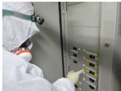
不要直流負荷の切離し操作 (安全補機開閉器室) (原子炉補助建屋T. P. 10. 3m)
