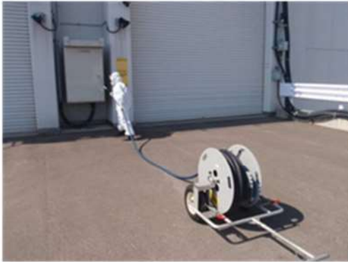
高圧ケーブル敷設 (屋外)
