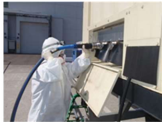
高圧ケーブル接続 (コネクタ) (屋外)
