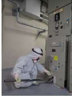
受電遮断器操作 (安全補機開閉器室) (原子炉補助建屋T. P. 10. 3m)
