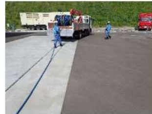
号炉間連絡予備ケーブル敷設（屋外）
