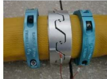
可搬型ホース（150A）接続後
