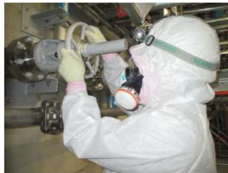
代替給水ピットから 補助給水ピットへの補給系統構成 (周辺補機棟 T.P. 17.8m)
