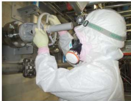
代替給水ピットから 補助給水ピットへの補給系統構成 (周辺補機棟 T.P. 17.8m)
