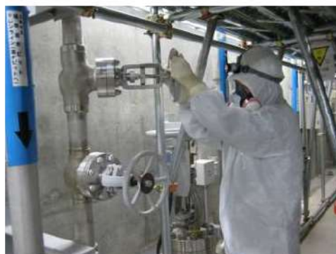
補助給水ピット供給 ライン系統構成 (周辺補機棟 T. P. 24. 8m)
