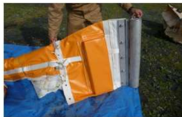
荷揚場シルトフェンス端部
