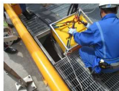
海水取水箇所への水中ポンプ設置 (屋外)
