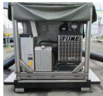
泡混合設備設置 (屋外)
