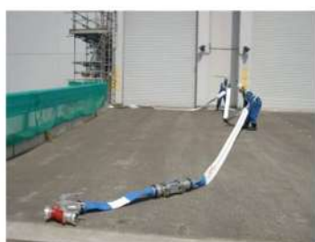
可搬型ホース敷設 （屋外）
