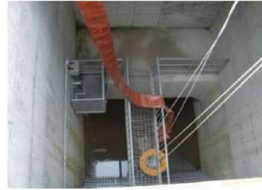
海水取水箇所への水中ポンプ設置 (屋外)
