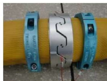
可搬型ホース（150A）接続後
