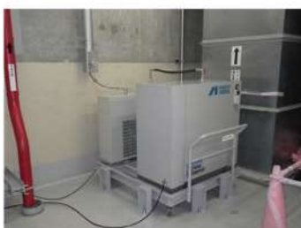
監視カメラ空冷装置
