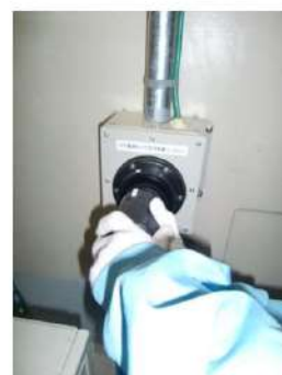
電源ケーブル接続
