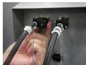
検出器用ケーブル接続
