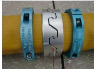
可搬型ホース (150A) 接続後
