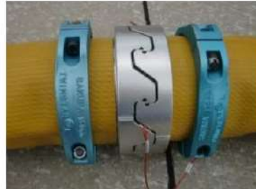
可搬型ホース(150A)接続後
