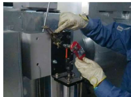
(空気作動ダンパ閉作業イメージ)
