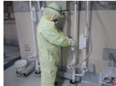
窒素供給操作 (系統側バルブ操作) (周辺補機棟 T. P. 40. 3m)
