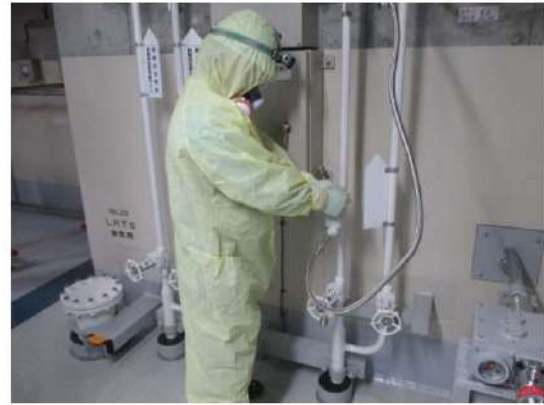
(制御用空気供給弁閉操作イメージ)
