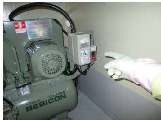
可搬型代替ガスサンプリング圧縮装置起動 (周辺補機棟 T. P. 24. 8m)
