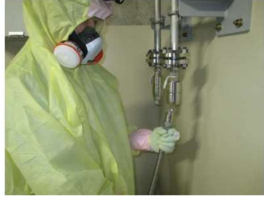
可搬型格納容器内水素濃度計測ユニット接続 (周辺補機棟 T. P. 24. 8m)
