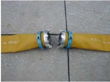
可搬型ホース(150A)接続前
