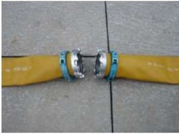
可搬型ホース（150A）接続前
