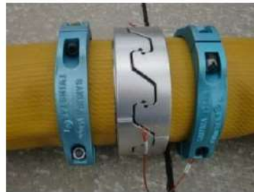
可搬型ホース（150A）接続後
