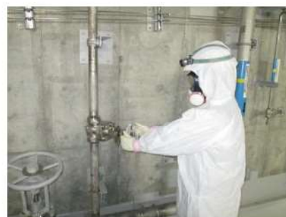
可搬型大型送水ポンプ車による原子炉格納容器下部への注水系統構成 （運転員（現場）C） （周辺補機棟 T. P. 10. 3m）
