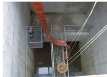
海水取水箇所への水中ポンプ設置 （屋外）
