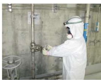
可搬型大型送水ポンプ車による原子炉格納容器内へのスプレイ系統構成 （運転員（現場）C） （周辺補機棟 T. P. 10. 3m）
