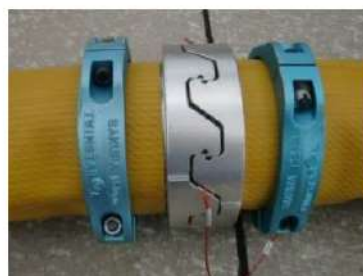
可搬型ホース(150A)接続後
