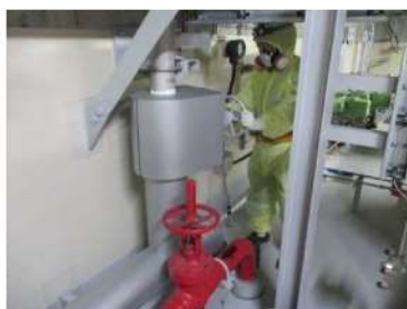
可搬型大型送水ポンプ車による原子炉格納容器内へのスプレイ系統構成 （運転員（現場）B） （原子炉補助建屋 T. P. 10. 3m）
