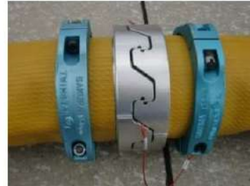
可搬型ホース(150A)接続後
