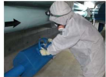
通水操作 (周辺補機棟 T. P. 2. 3m)
