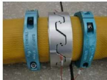
可搬型ホース(150A)接続後
