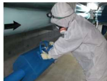
通水操作 (周辺補機棟 T.P. 2.3m)
