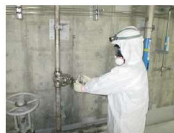
可搬型大型送水ポンプ車による原子炉容器への注水系統構成 (運転員 (現場) C) (周辺補機棟 T.P. 10.3m)
