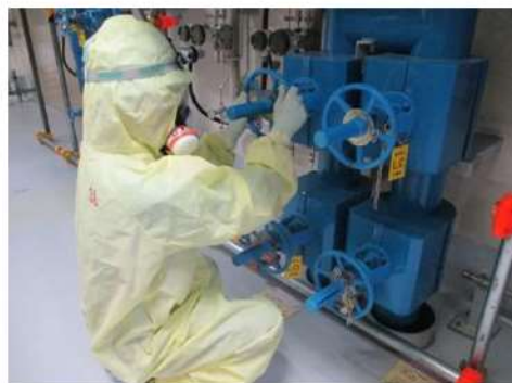
B-充てんポンプ自己冷却運転系統構成 （原子炉補助建屋 T.P. 10. 3m）
