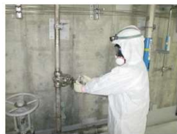
可搬型大型送水ポンプ車による原子炉容器への注水系統構成 (運転員 (現場) C) (周辺補機棟 T.P. 10.3m)
