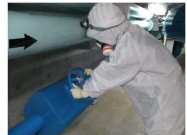
通水操作 (周辺補機棟 T.P. 2.3m)
