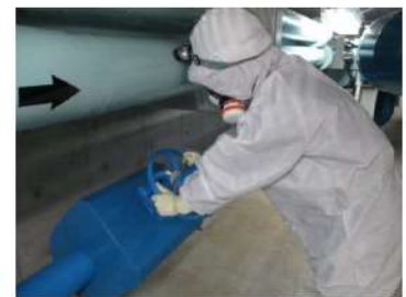
通水操作 (周辺補機棟 T.P. 2. 3m)
