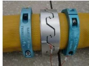
可搬型ホース(150A)接続後
