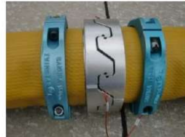
可搬型ホース (150A) 接続後
