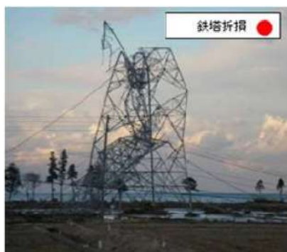
津波による隣接鉄塔の倒壊に伴う送電鉄塔の倒壊事例 ※2
