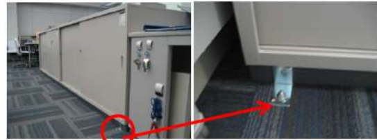
図11 キャビネットの固定
